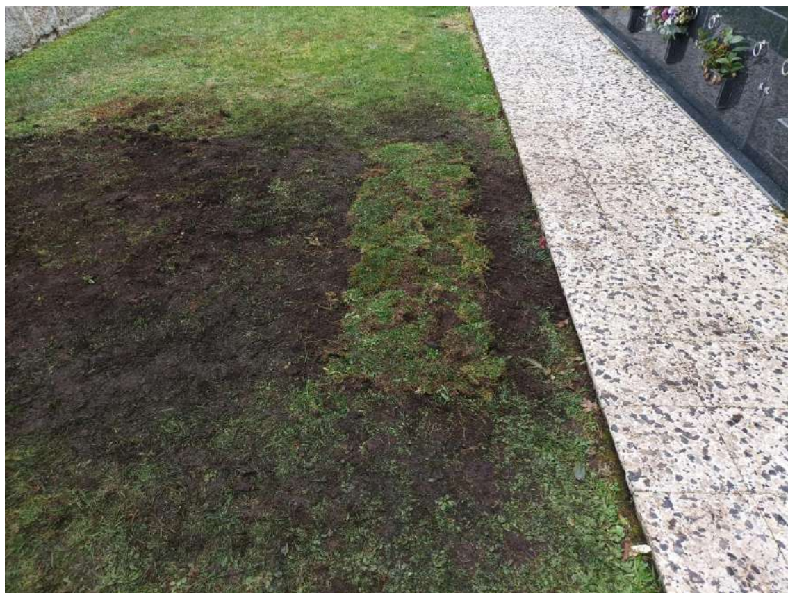
Figura 42. Detalle do tapado e restitución das sondaxes.
