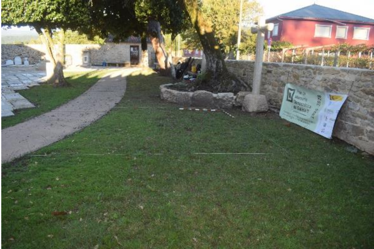
Estado inicial da zona de intervención, vista desde o SE
