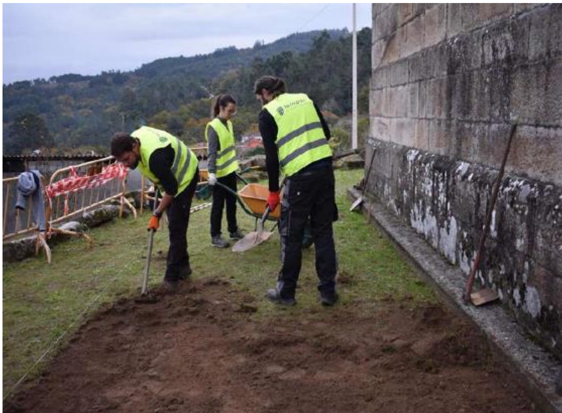
Traballos de escavación na Igrexa de San Pedro de Filgueira
