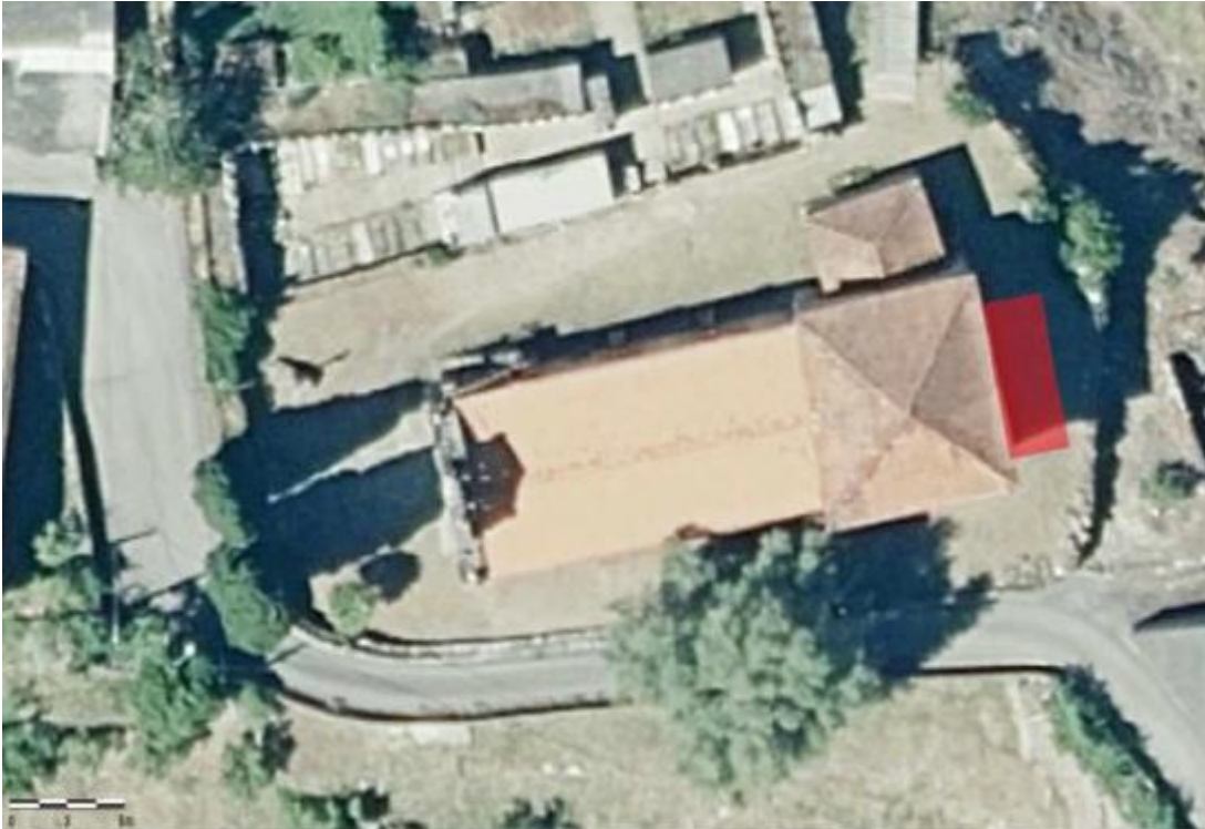
Zona da intervención arqueolóxica na Igrexa de San Pedro de Filgueira
