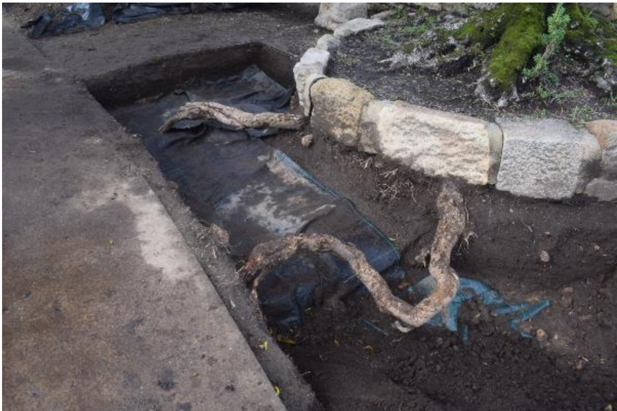
Colación de xeotextil zona W, vista dende o SE
