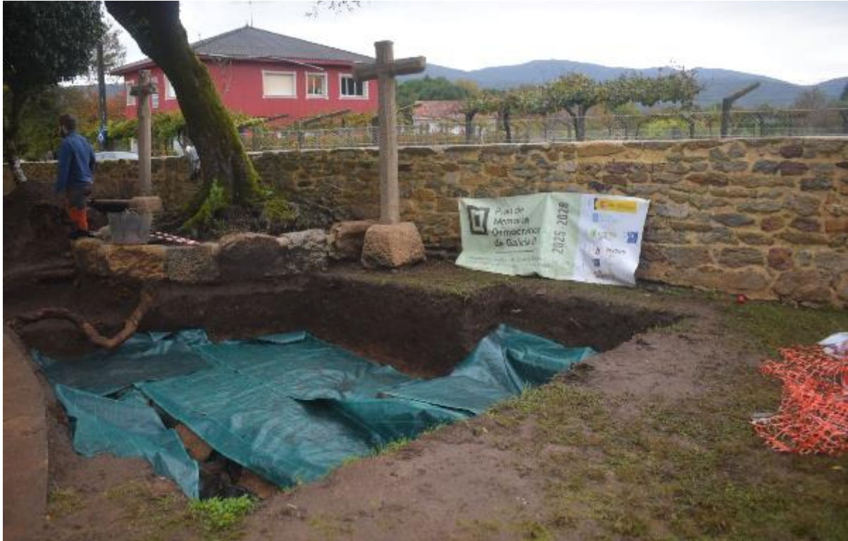
Colación de xeotextil zona E, vista dende o SE
