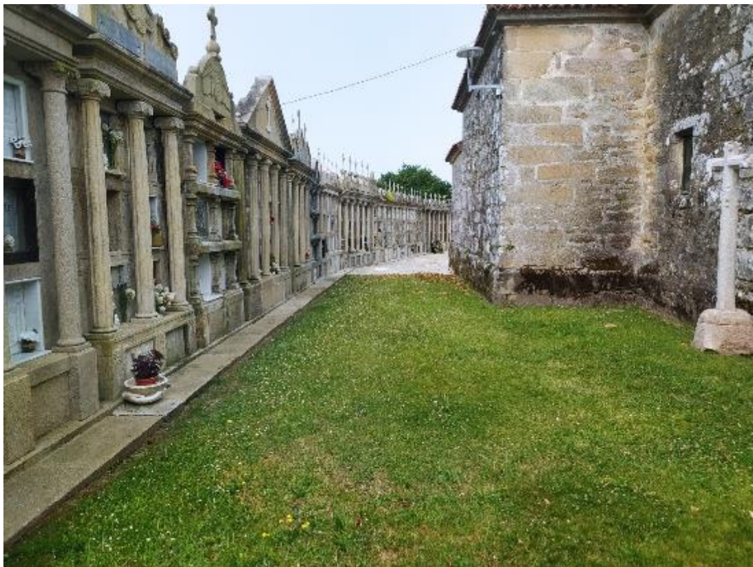
Detalle do lateral S do cemiterio, vista dende o E
