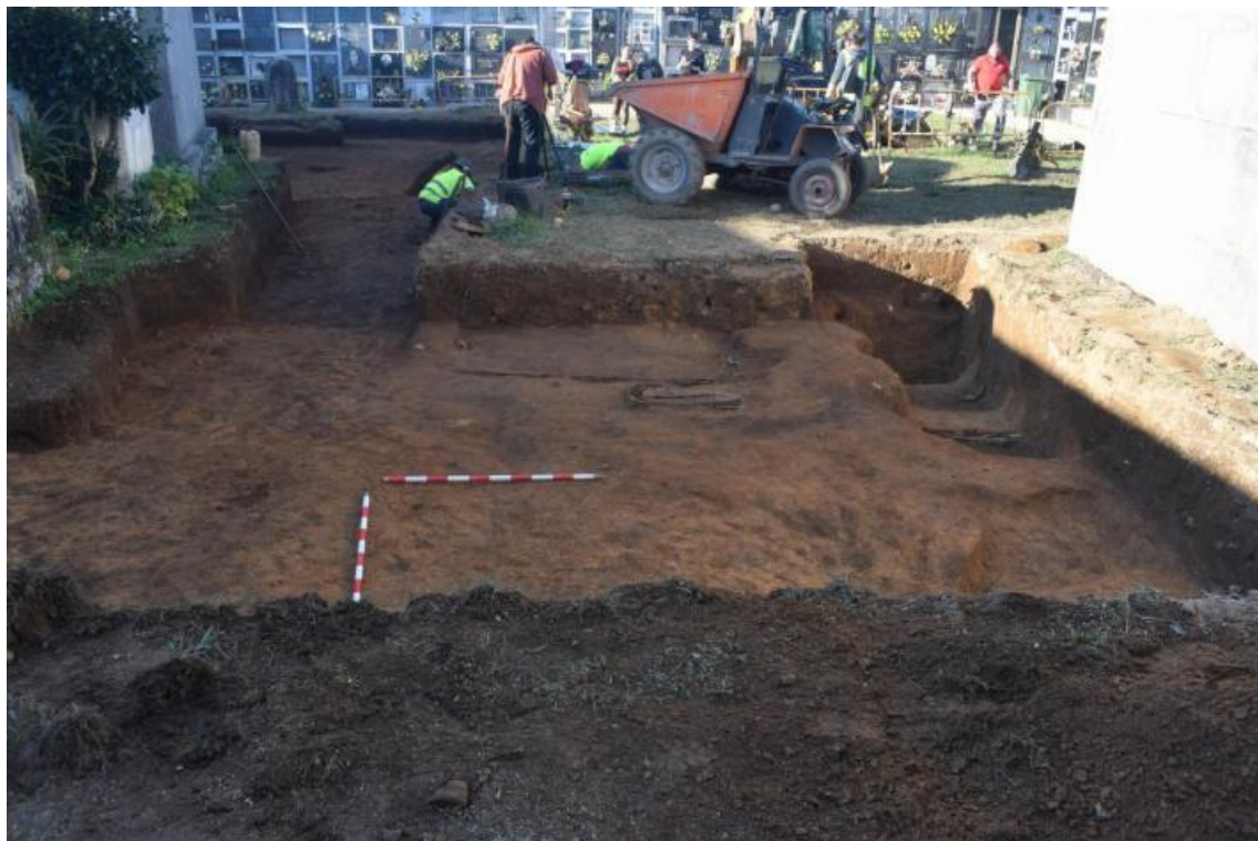
Imaxe 74. Estado final sector 200. Vista dende o S.
