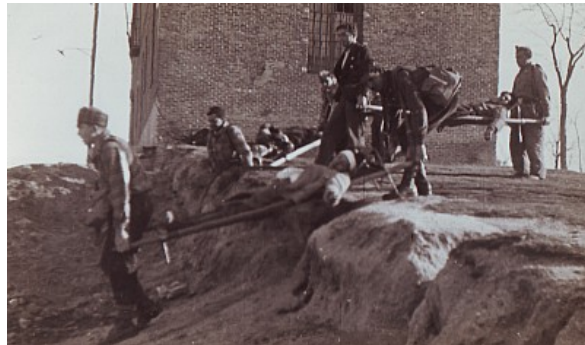
Sanitarios en el frente de Madrid 10
